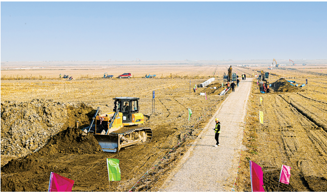
位于杭州湾上虞经济开发区的4200亩高标准农田建设项目正抓紧建设中。 本报记者 叶敏 摄
