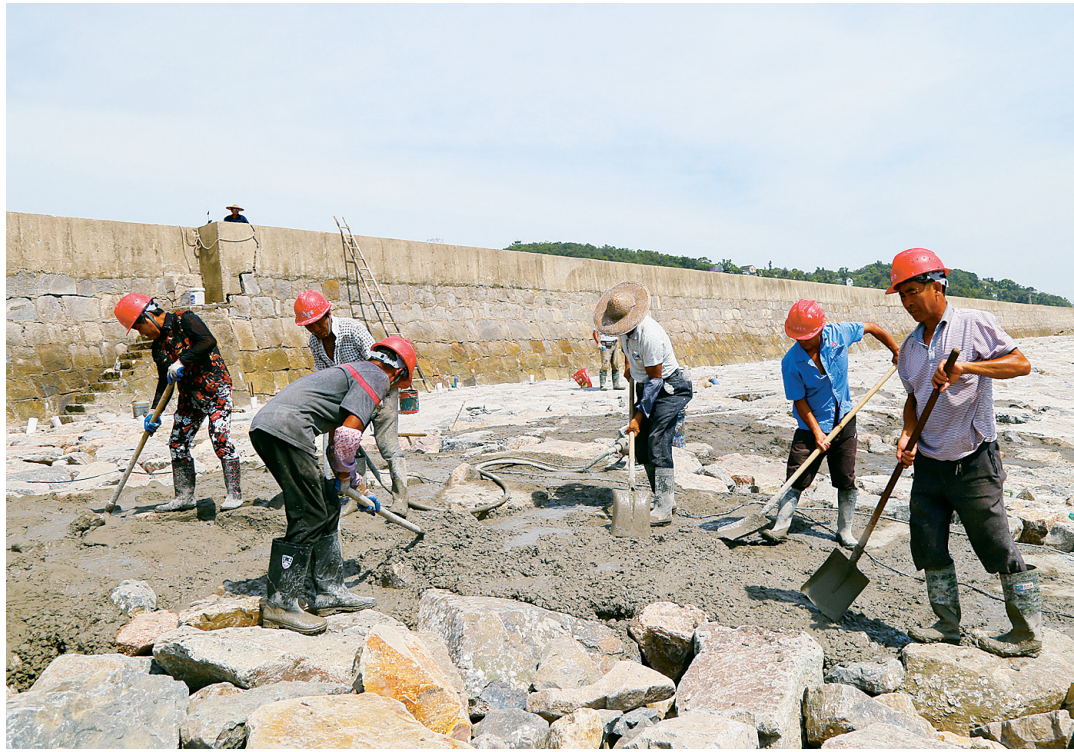
日前,在玉环市干江镇礁门塘及配套水闸除险加固工程工地上,工人们冒着高温在灌砌石中填筑混凝土,确保海堤汛期安全。 吴达夫 摄
