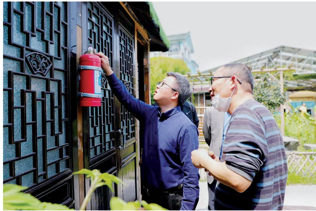
近日,湖州市农业农村局组织开展农家乐安全生产大检查,排查安全隐患。
