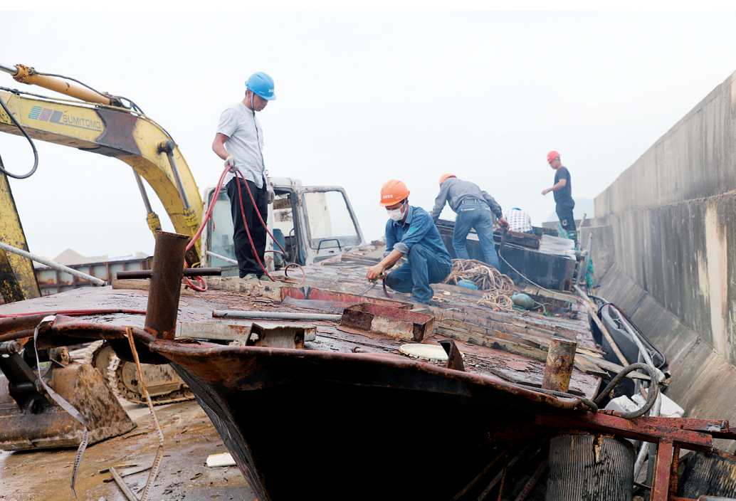
近日,温岭市松门镇农渔办接到群众反映,在石板殿村原金港船厂发现一艘疑似“三无”船只。该镇农渔办联合港航口岸与渔业管理局人员,立即赶到船厂,经调查,确认该船为“三无”船舶。因为执法人员正在拆解“三无”船只。
